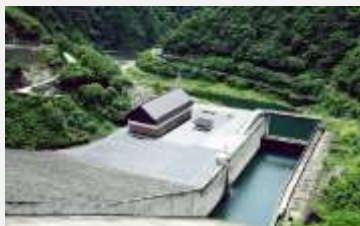
発電所 取水路等
