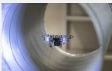
ダクト 配管内部
